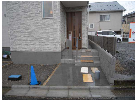
現場監査（西東京市谷戸町）
