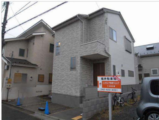
現場監査（西東京市谷戸町）
