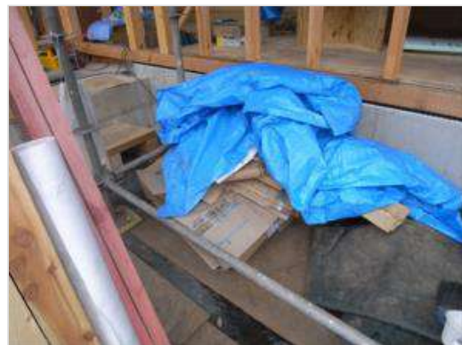
段ボール一時保管場所
