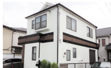
戸建リフォーム（施工例）
