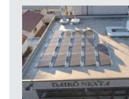
環境負荷の軽減を目的とし、本社の屋上に太陽光発電システムを設置しました。年間の発電量は6,831kWhで、最大発電時は当社の使用電力量の約20%を出力することができます。また、再生可能エネルギーによる環境負荷の少ない発電が実現し、CO2排出量を年間3.7t削減することができました。
