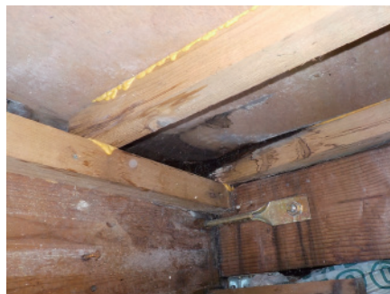
バルコニー排水口部 保護モルタル下 防水の劣化による雨漏り
