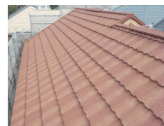
清瀬市F邸 板金屋根カバー工法施工後
