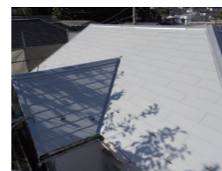
杉並区T邸 遮熱コロニアル葺き替え施工後
